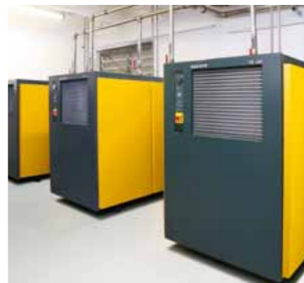
I kod završne obrade (lijeva i desna strana) je komprimirani zrak iz nove Kaeser Kompresoren-stanice neophodan
