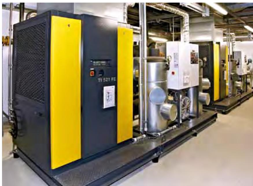
Dva Hybritec kombinirana sušača održavaju tlačnu točku rosišta komprimiranog zraka sigurno na  $-35^{\circ}\text{C}$  (lijevo), zato što su ovdje na liniji rezanja (gore) „svježe temperature“
